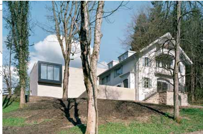
Von unten kommend, steht der Neubau in zweiter Position und lässt dem Altbau, dem bisherigen Museum, den Vortritt.
